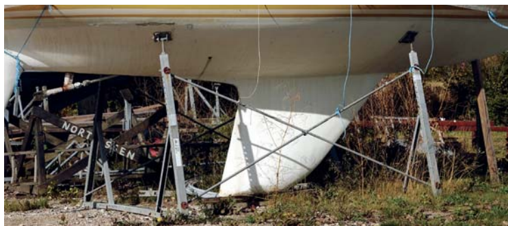
Denne båd står helt korrekt i et ældre stativ, der er godt afstivet med langs skibs kryds og skrå tværstivere. Stativets støtter er korrekt vinklet ind mod båden, og de støtter fint på bådens bælg.
