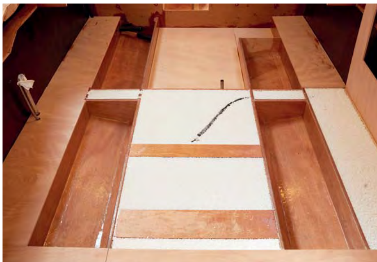
Alle rum under dørken, der ikke skal udnyttes, er fyldt med polystyren granulat, der er rørt om med epoxy. Forrest i billedet ligger benzintanken af stål indpakket i dette komposit.
