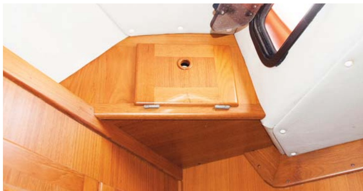
Det er ikke altid så let at skaffe sig adgang til bagsiden af gennemføringerne. De er som regel pakket godt ind bag forskellige apteringsdetaljer. Men der er ingen vej udenom.
